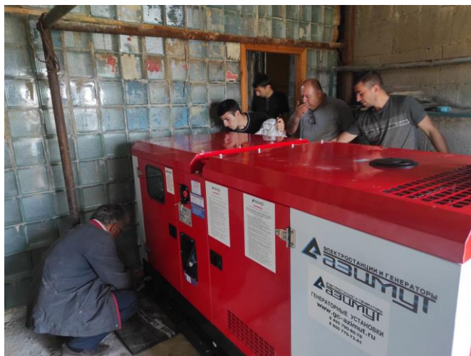
Նկար 1. Դիզելային գեներատորի տեղադրումը Արագած բարձր լեռնային գիտահետազոտական կայանում:
