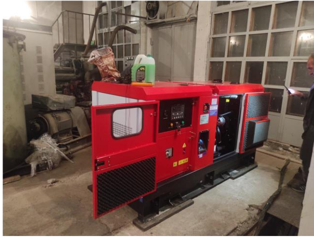
Նկար 2. Դիզելային գեներատորի տեղադրումը Նոր Ամբերդ բարձր լեռնային գիտահետազոտական կայանում:
